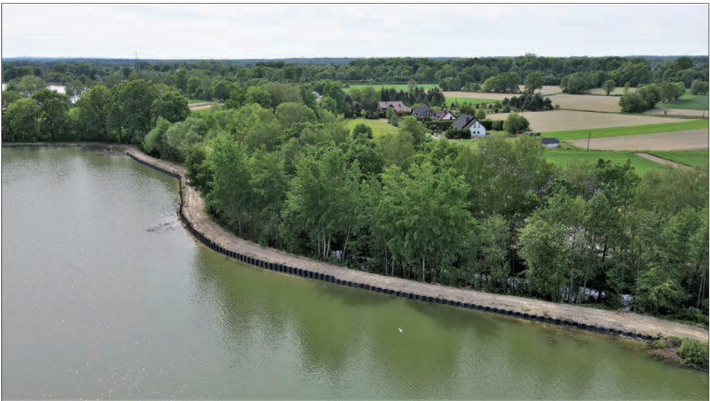
Fot. 1. Zabezpieczenie grobli na stawie Barzyniec (fot. M. Sottysik/SOLEY).
