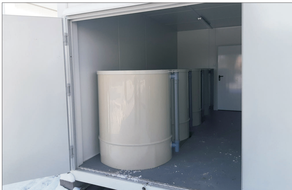
Fot. 5. Widok gotowego kontenera hodowlanego wyposażonego w cztery baseny rotacyjne do podchowu i przetrzymywania tarlaków ryb, Zakład Rybactwa Jeziorowego w Giżycku (fot. D. Ulikowski).
