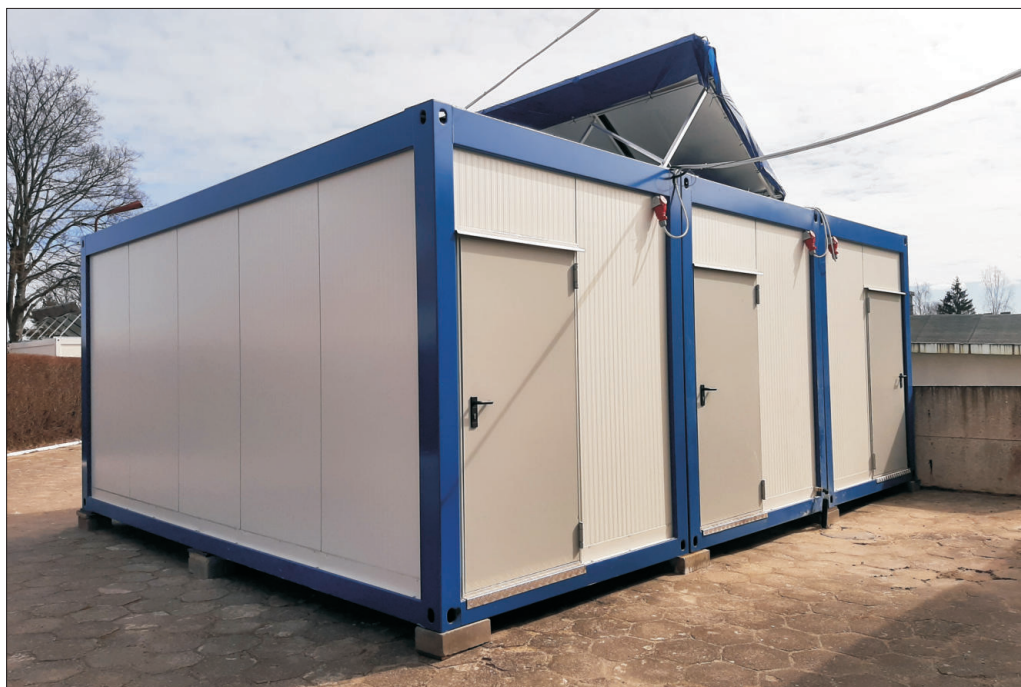
Rys. 6. Widok finalnego ustawienia zestawu trzech kontenerów z widocznymi kolektorami solarnymi na dachu kontenera technicznego, Zakład Rybactwa Jeziorowego w Giżycku (fot. D. Ulikowski).
